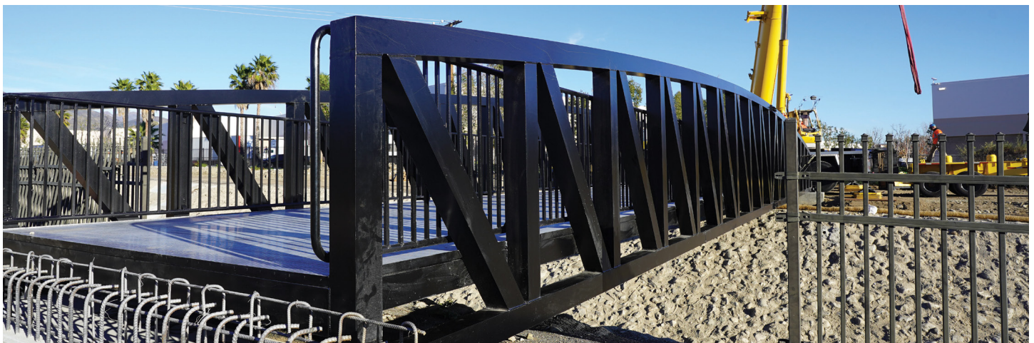
INSTALACION DEL PUENTE DEL ARROYO PACOIMA (PACOIMA WASH)
