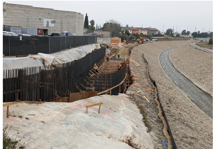
CONSTRUCCION DEL SENDERO DEL ARROYO PACOIMA (PACOIMA WASH)
