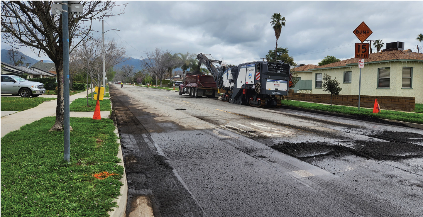
REPAVIMENTACION DE CALLES
