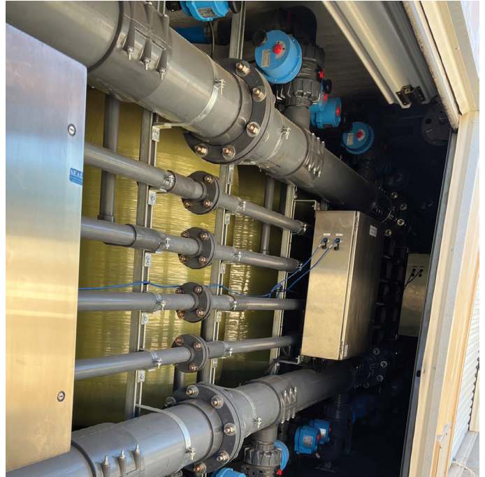
INSTALACION DE UN NUEVO SISTEMA DE FILTRACION DE NITRATOS DE AGUA
