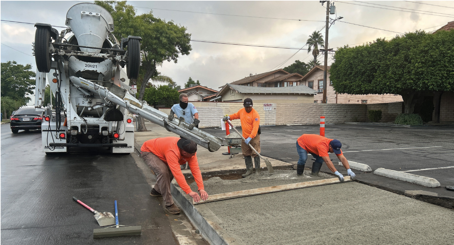
REPARACION DE BANQUETAS
