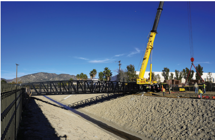
INSTALACION DEL PUENTE DEL ARROYO PACOIMA (PACOIMA WASH)
