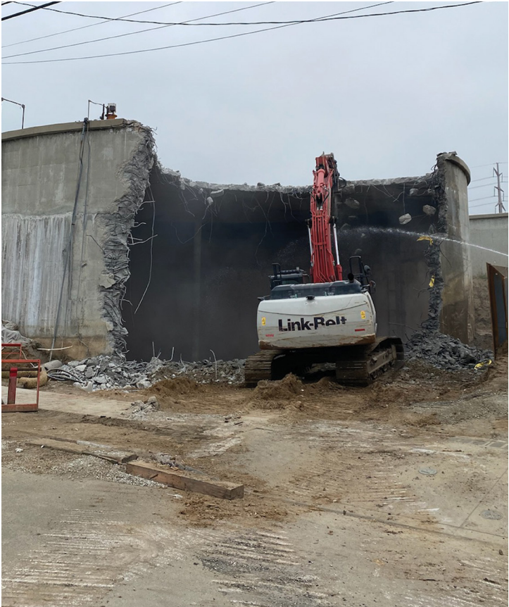
DEMOLICION DE EMBALSES
